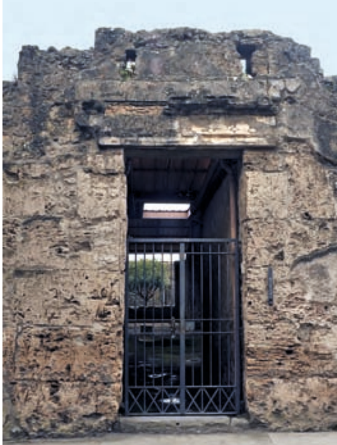
FIG. 30 - CASA DEL LARARIO DI ACHILLE. L'ingresso. © SSBAPES.
